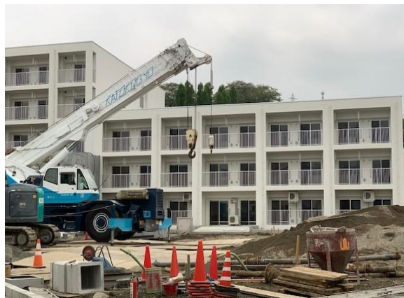
竣工に向け工事が進む県営団地
