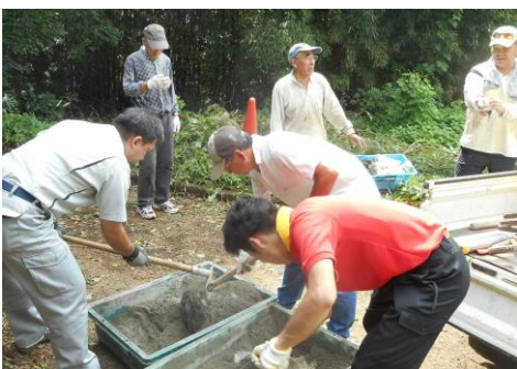
散策路の標識設置工事(17日)
