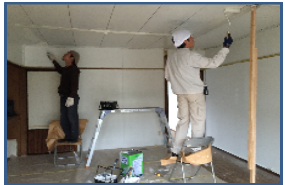
改装工事が急ピッチで進んでいる
