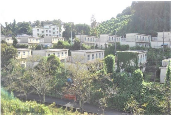
来年から建替えが始まるテラス棟の再生計画が出そろったことになる。
