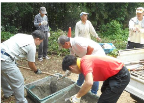
散策路の標識設置工事(17日)
