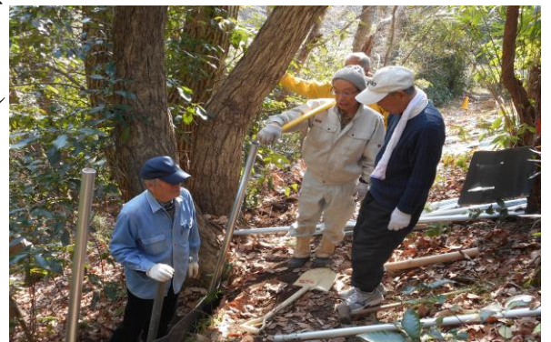
パイプを打ち込み土留めを作る
