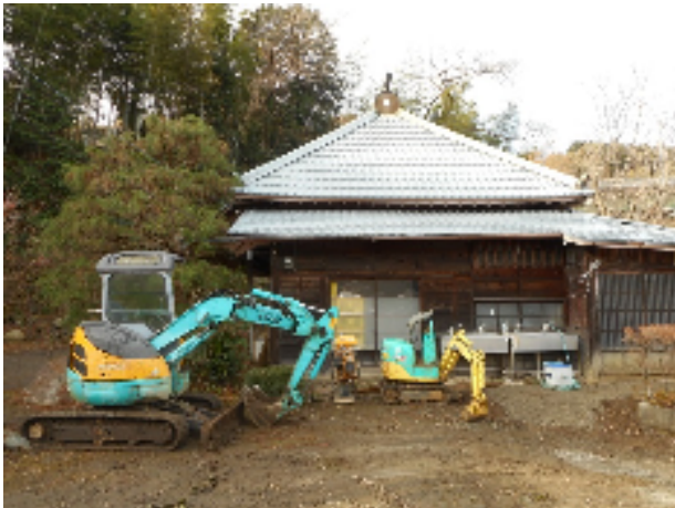
改修工事は順調に進んでいる
